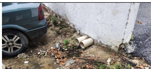
Figura 5: Rede pluvial lançando no estacionamento. Fonte: COSAMA, 2025
