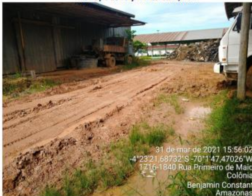
Foto 08: Entrada da área do aterro de resíduos sólidos, com a localização e os pares de coordenadas geográficas no Município de Benjamin Constant/AM.
