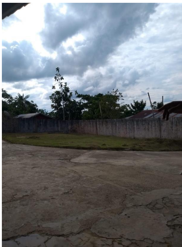
Local para execução das Bases da ETA
